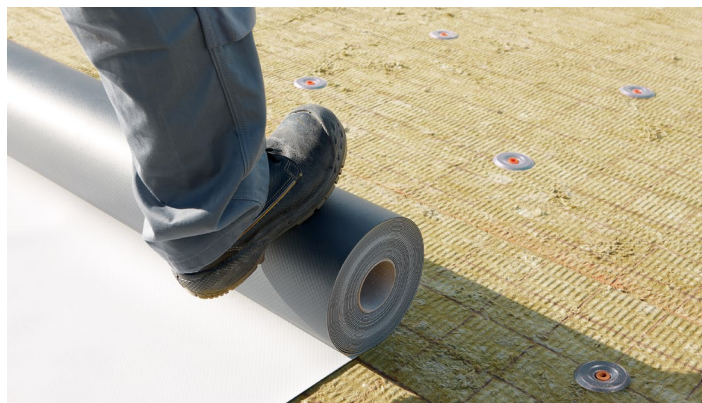
2. Rozwinięcie pokrycia dachowego, zgrzanie zakładów
