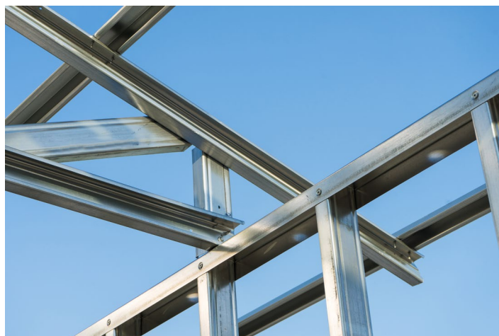
Lekkie konstrukcje stalowe
